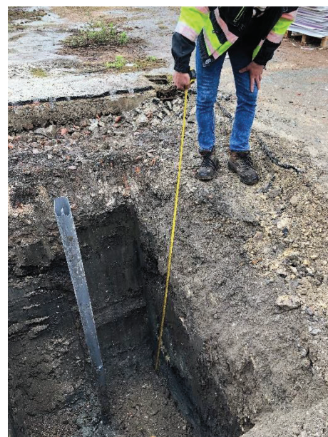
Calicata tras extracción de tierras (11/04/19)
