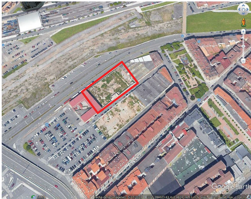
Figura 2. Vista aérea de las instalaciones (2018).
